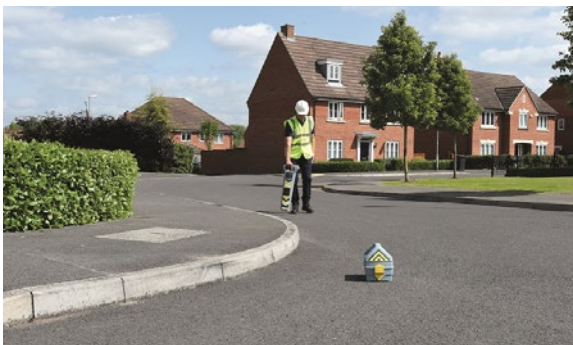
Abb. 8 Aktive Ortung, im Vordergrund Sender zur Signaleinkopplung
